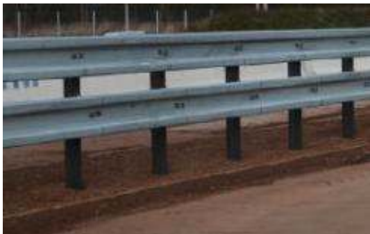
Obrázok 15: Pohľad na zvodidlo BRBV4-JC/H3
