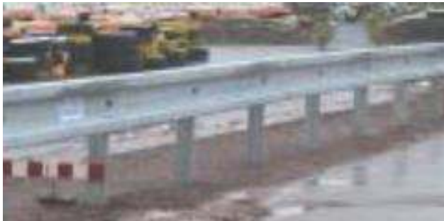
Obrázok 11: Pohľad na zvodidlo BRBV4-JC/H2 Obrázok 12: Krátky výškový nábeh zvodidla BRBV4-JC/H2
