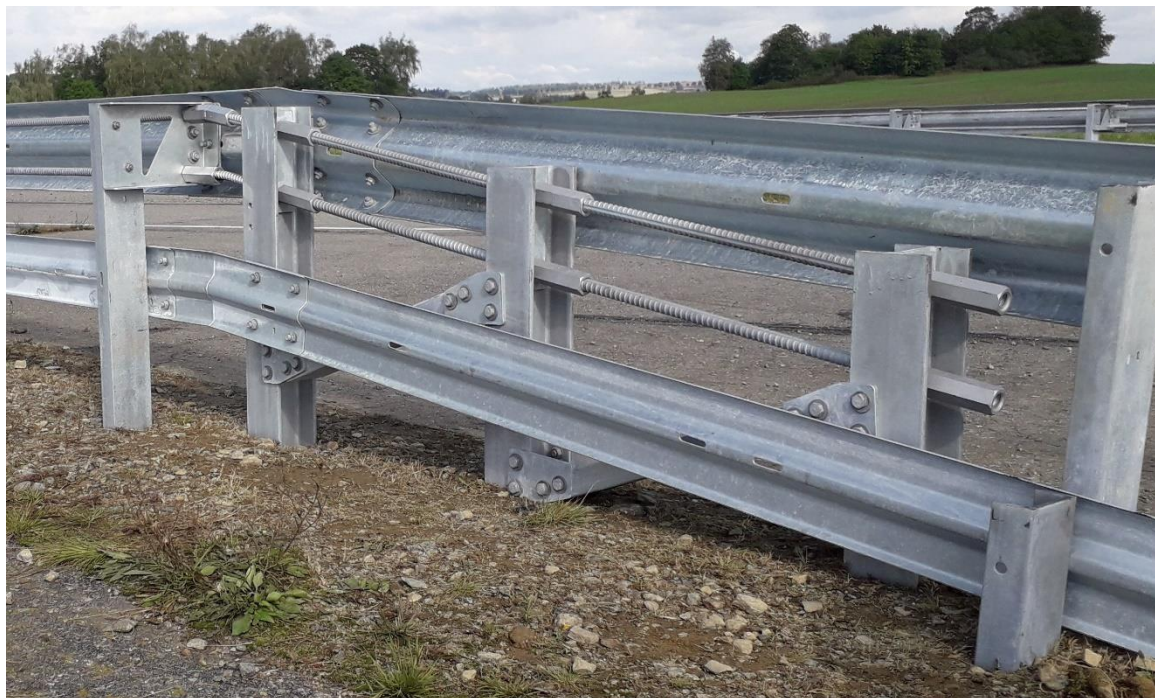
Obrázok 111 – Pohľad z rubu na ukončenie tyčí zvodidla JS3A-2/H3-1, (v mm)
