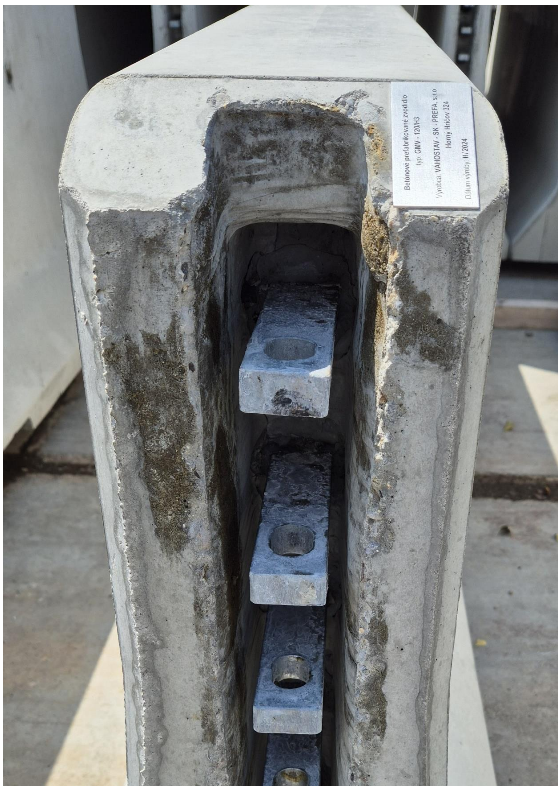
Obrázok 11 – Trvanlivé značenie štítkom
