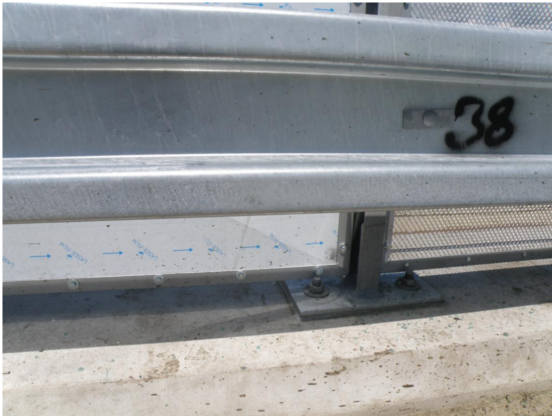
Obrázok 23 – Zábradľové zvodidlo ZMS4/H3 – pohľad na plnú výplň a výplň z ťahokovu
