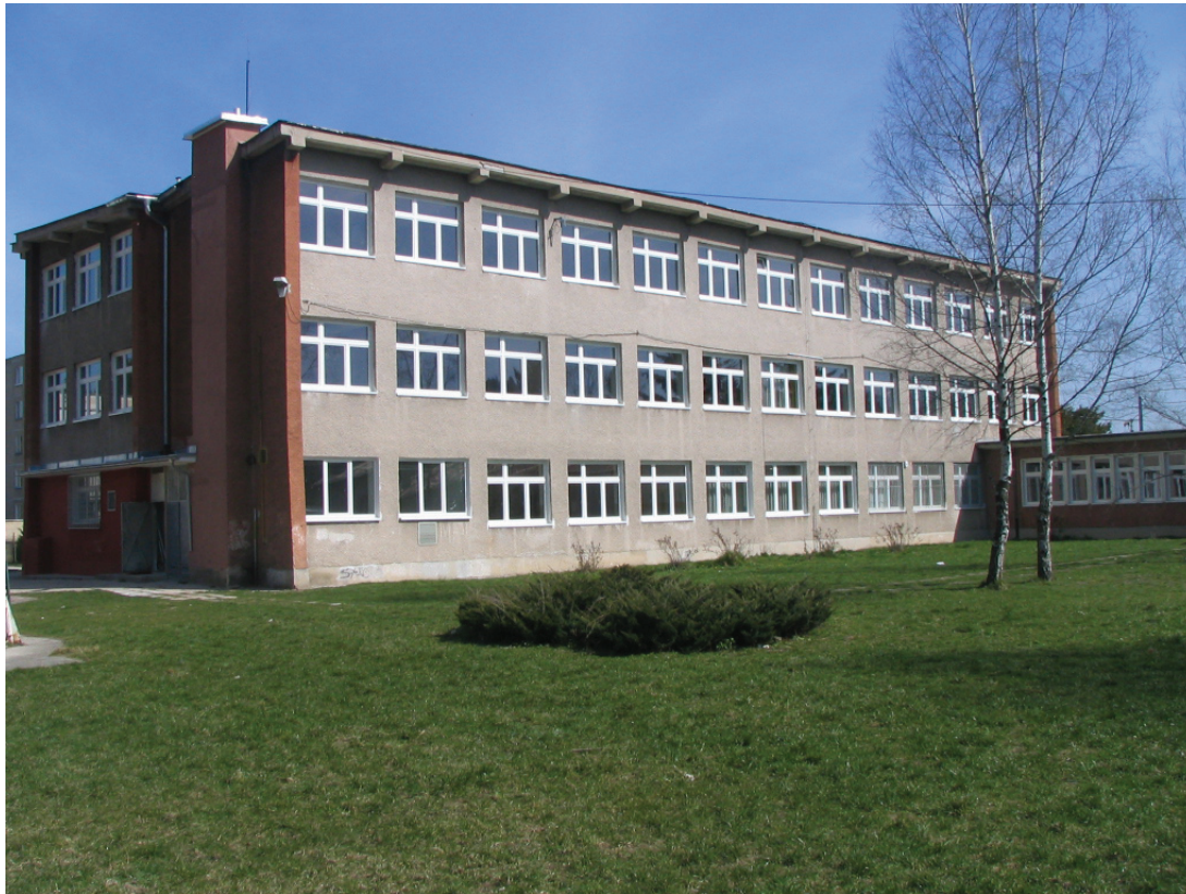
Obr. 4.3 Pohľad na južné a západné priečelie posudzovanej typovej budovy základnej školy
