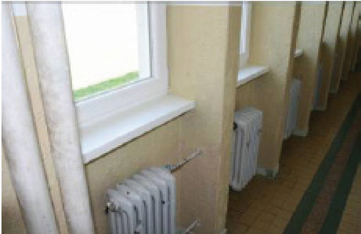
Obr. 3.4 Pohľad na parapetné murivo zvyšujúce tepelné straty
