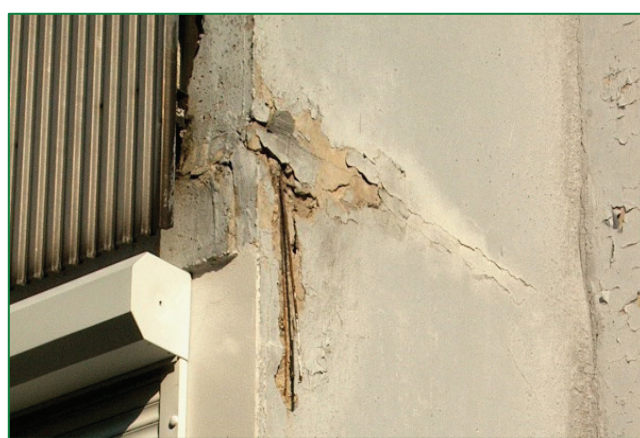
Zdegradovaná zálievka styku lôžiovej nosnej steny Degraded filler of the joint of a loggia bearing wall
