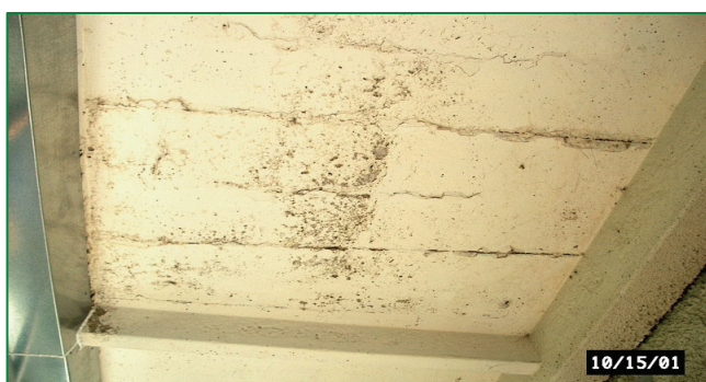
Trhliny a korózia výstuže v stropnej lôžiovej doske Cracks and corrosion of reinforcement in a ceiling loggia board
