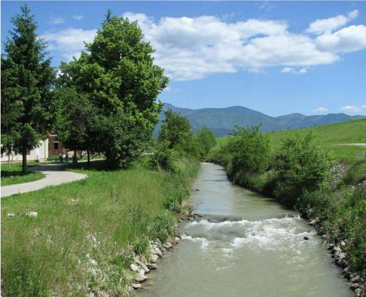
Obr. 2-9 Vodné dielo Žilina - biokoridor
