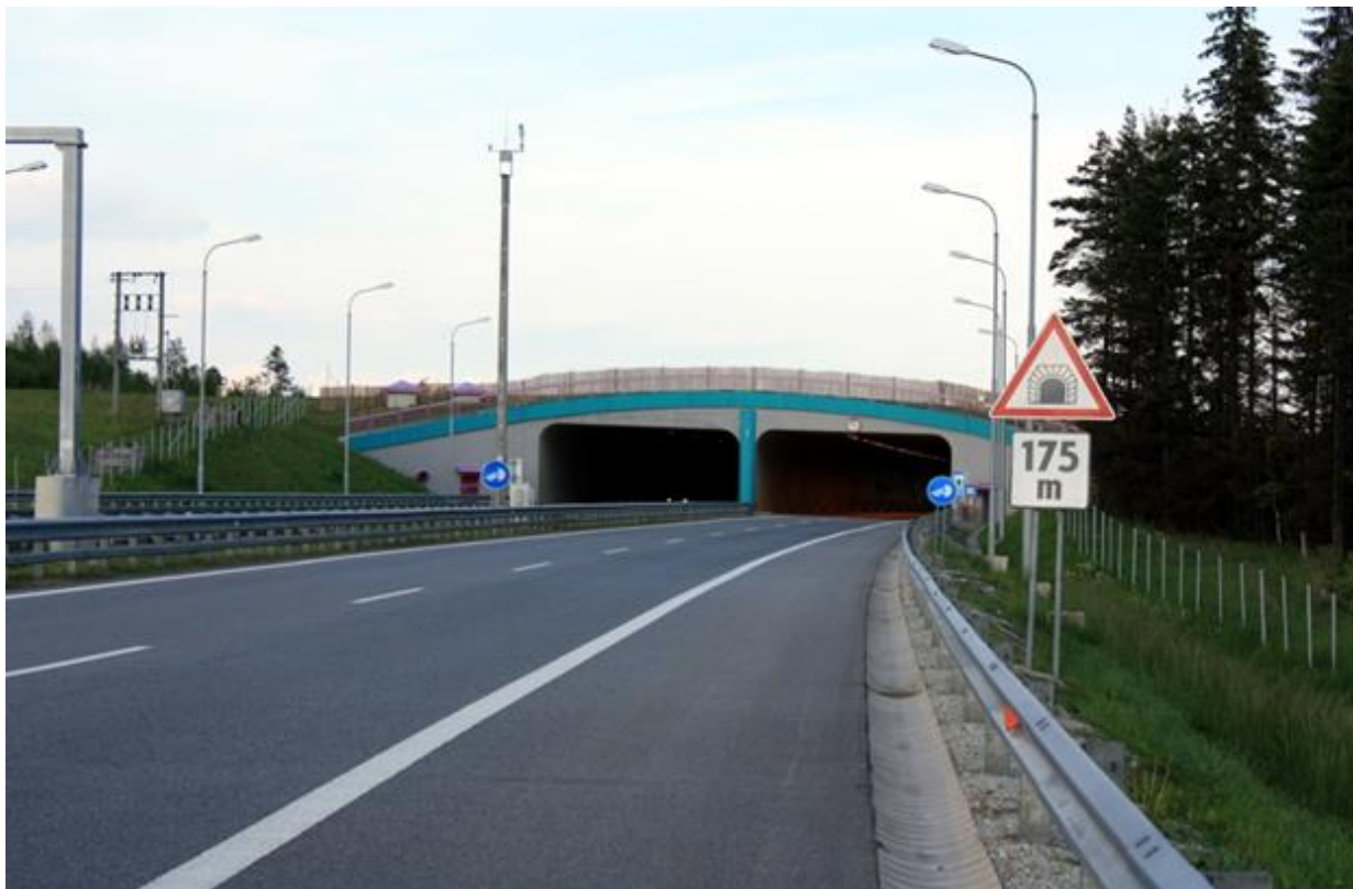
Obr. 2-3 Priechod pre zver na úseku D1 Mengusovce – Jánovce
