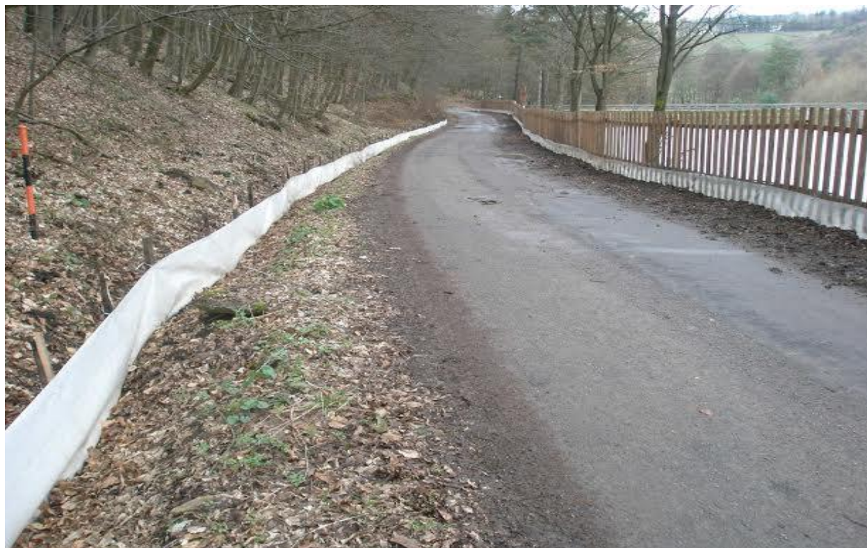
Obr. 2-7 Umiestnenie fóliových zábran na lokalitách migrácie obojživelníkov
