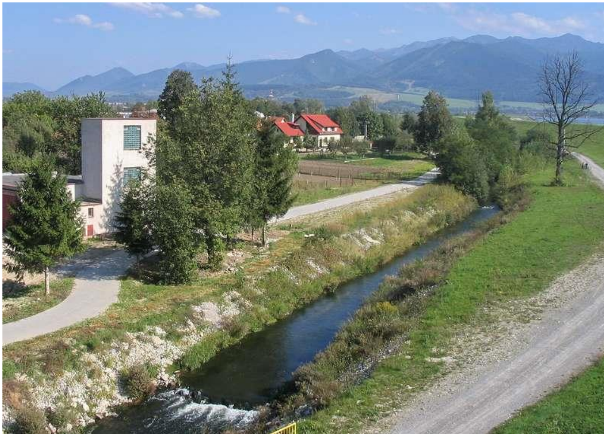
Obr. 2-9 Vodné dielo Žilina - biokoridor
