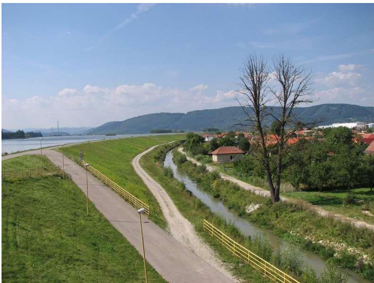
Obr. 2-89 Vodné dielo Žilina - biokoridor
