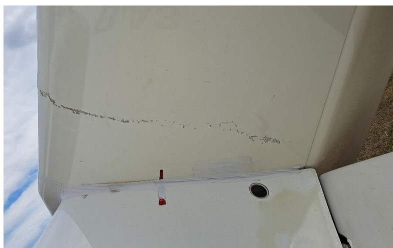
Obr. č. 4 delaminácia/popraskanie spodného poťahu horizontálneho stabilizátora
