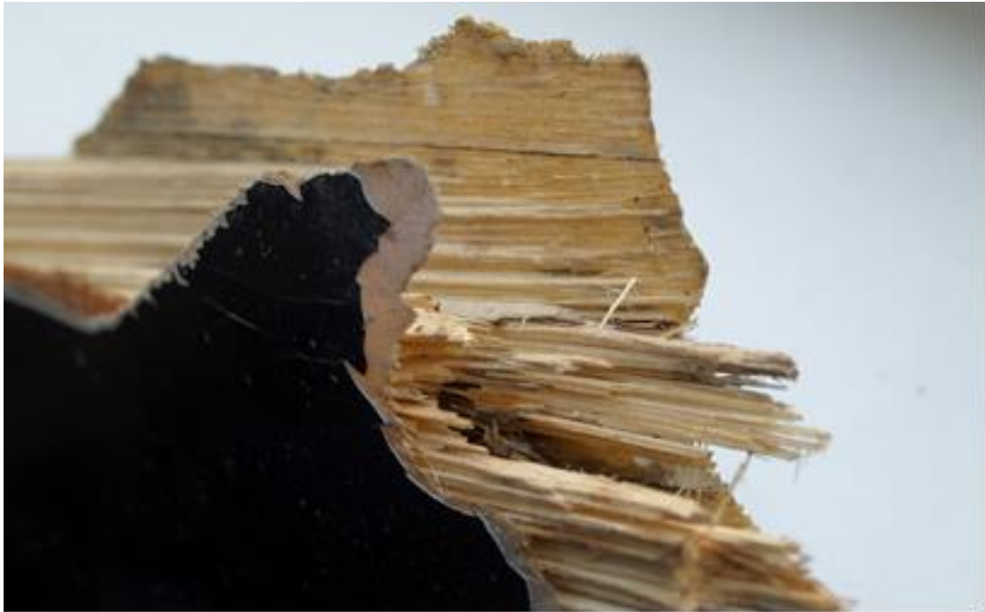
Obr. 25 Výrazné pozdĺžne praskliny a chýbajúci materiál v zadnej časti listu vrtule
