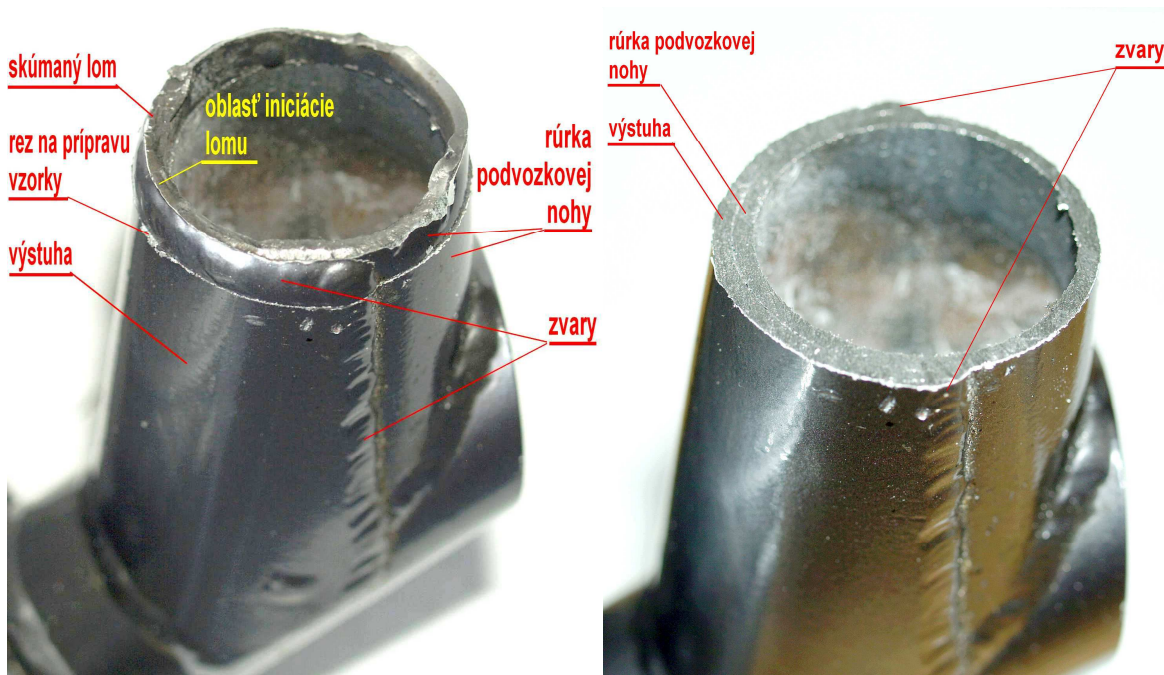
Oblasť iniciácie lomu v spodnej časti poškodeného prierezu podvozkovej nohy
